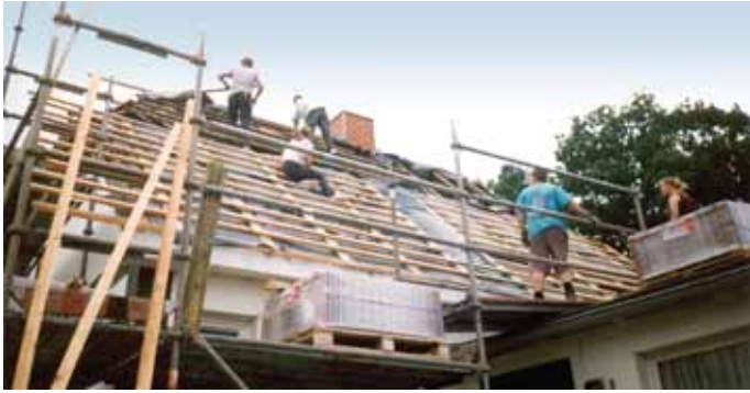
Mit vorschriftsmäßigem Gerüst wird das neue Dach vorbereitet
