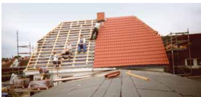
Die JUH-eigene Dachdeckerkolonne des OV Stade unter der fachmännischen Leitung von Thomas Helmke
