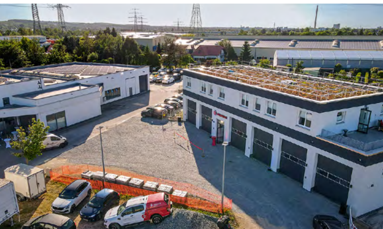
Aus einem verlassenen Autohaus haben die Johanniter nach und nach ein leistungsfähiges Zentrum für den Katastrophenschutz geschaffen.
