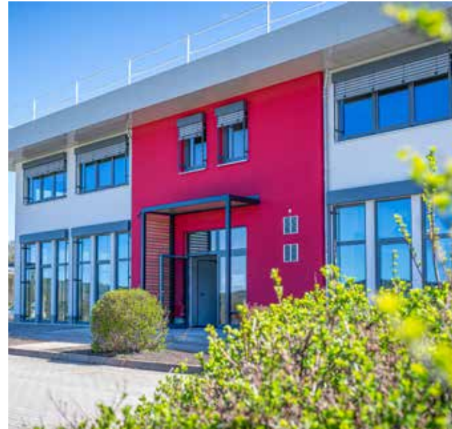
Von Außen erstrahlt das »Akkon« Aue bereits in neuem Glanz. Im Innenbereich sind noch ein paar letzte Handgriffe notwendig.
