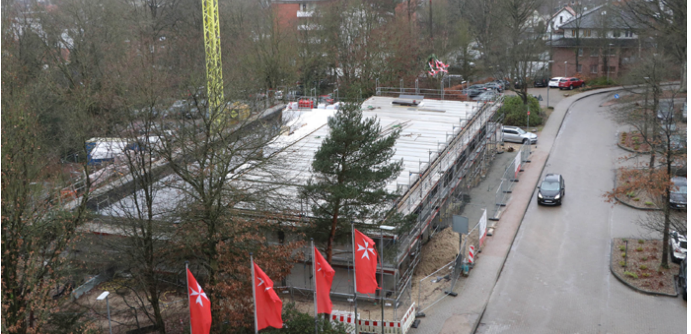
Blick auf den Neubau der Rettungswache
