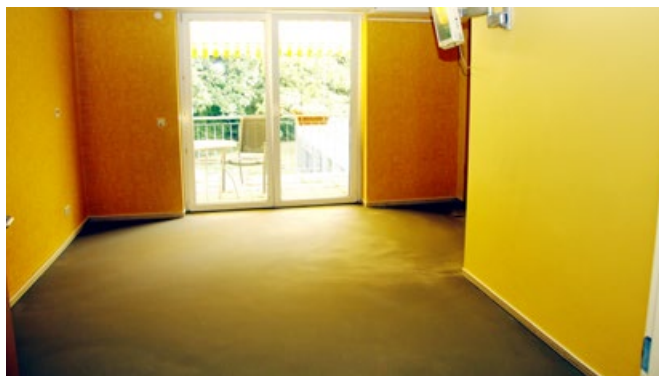
Der neue Estrich im ersten Zimmer wurde bereits gegossen
